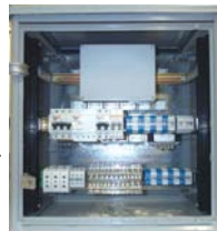
Controllo riscaldatori scambi
