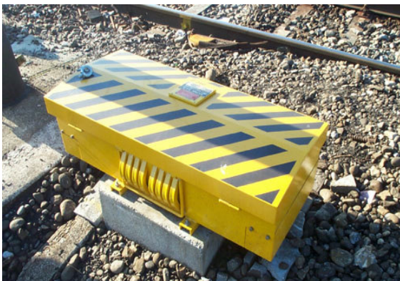
Trasformatore per resistenze (tipo nuova generazione)
