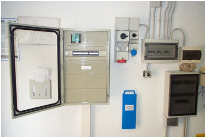
installazione unità di controllo
