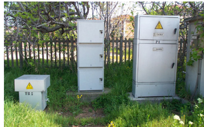
Cesena (cabina lato Bologna)
