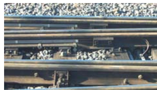
Controllo riscaldatori scambi
