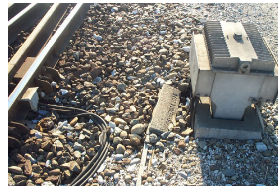
Trasformatore per resistenze (tipo vecchia generazione)
