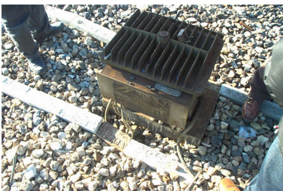
Trasformatore per resistenze (tipo nuova generazione)
