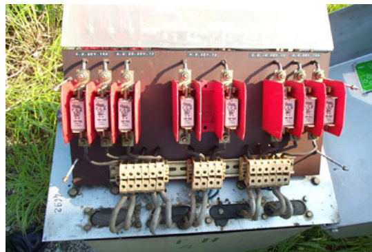
Trasformatore 380V/55V (resistenze)
